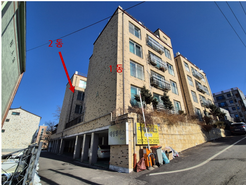
본 건물 전경 (남측에서 촬영)
