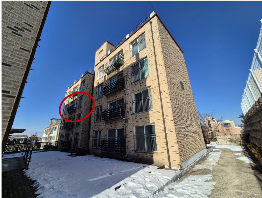
본건 전경 (남동측에서 촬영)
