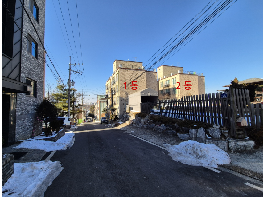
본 건물 전경 (동측에서 촬영)
